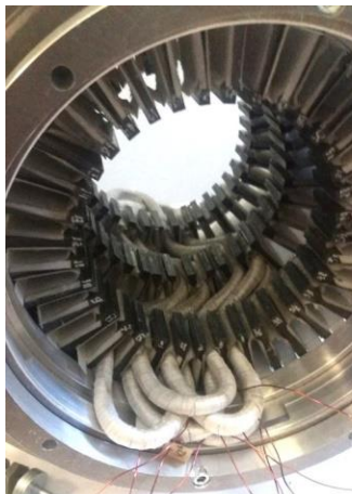
Рис. 5. Укладка обмотки якоря МПСБР
