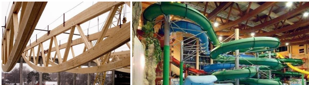
Рис. 5. Аквапарк. Ферма прольотом 44 м. Ферми покриття в аквапарку
