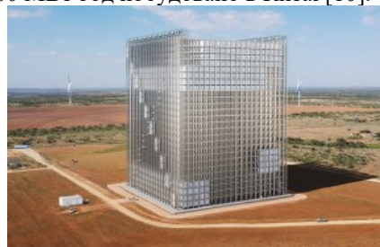
Рис. 4. Гравітаційний акумулятор G-VAULT, компанії Energy Vault
