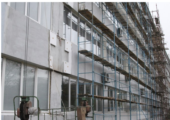
Рис. 5. Роботи з утеплення стін корпусів
